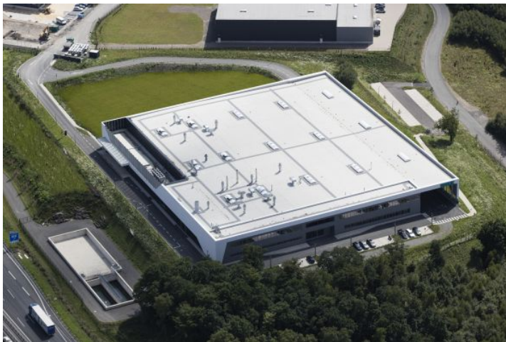
Luftansicht des neuen BENSELER-Werks in Lüdenscheid, Wibscha. (Bildquelle: BENSELER)
