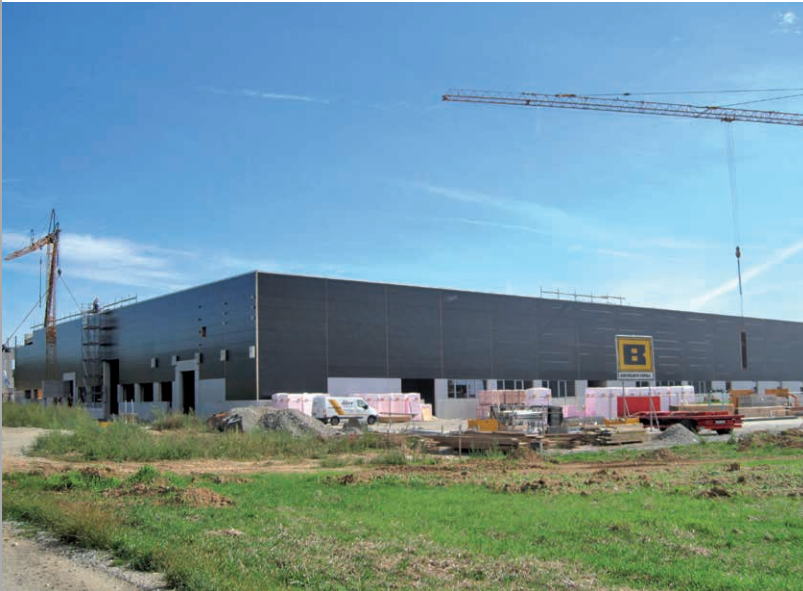
Die Bauarbeiten am neuen BENSELER-Werk in Bogen gehen zügig voran. Läuft weiterhin alles nach Plan, kann hier bereits ab Anfang 2016 die Produktion starten.
